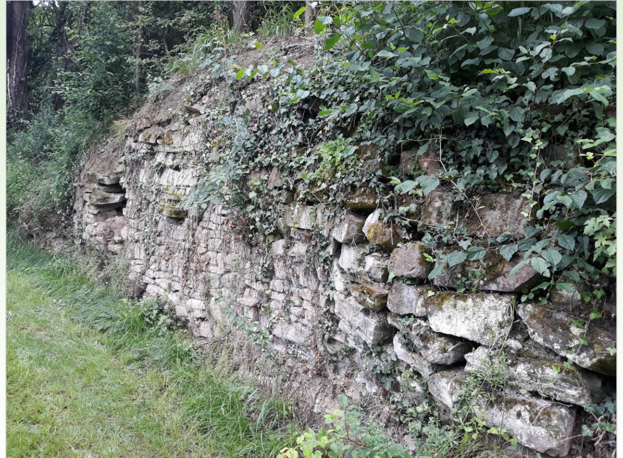
Foto 1: Beispiel für eine Sanierung von Trockenmauern
