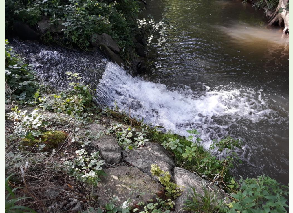
Foto 4: Verbauter Mündungsbereich mit Sohlschwelle
