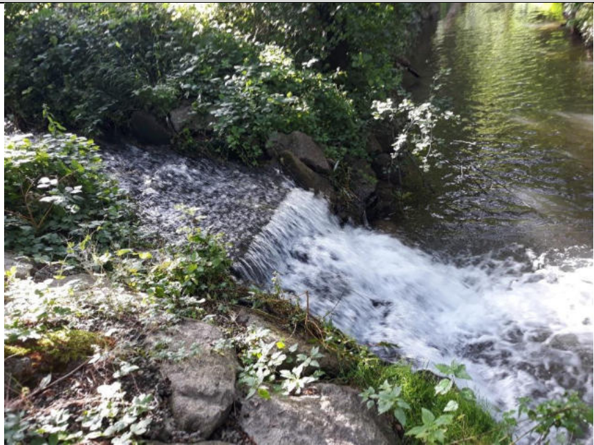
Foto 36: Verbauter Mündungsbe- reich mit Sohlschwelle
