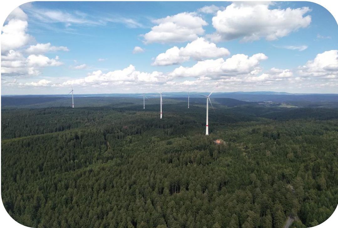
Windpark Roskopf (16,5 MW), Hessen, Inbetriebnahme 2020
