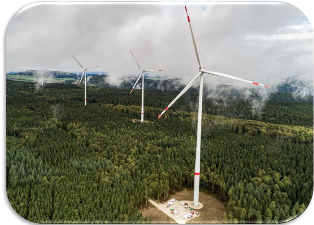
Windpark Junge Donau (21 MW), Ba.-Wü., Inbetriebnahme 2023
