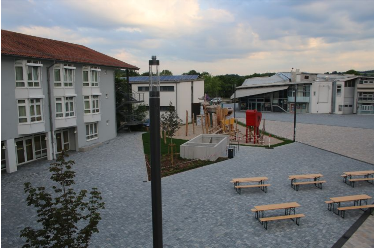
Neben einem Anbau der Diakoniestation (rechts) ebnete der Remchinger Gemeinderat mit einer Bebauungsplanänderung an der Neuen Ortsmitte den Weg für die Altenheimerweiterung. Foto: Zachmann
