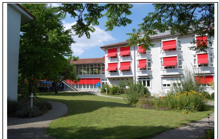
Neben einem Anbau der Diakoniestation ebnete der Remchinger Gemeinderat mit einer Bebauungsplanänderung an der Neuen Ortsmitte den Weg für die Altenheimerweiterung. Foto: Reichert
