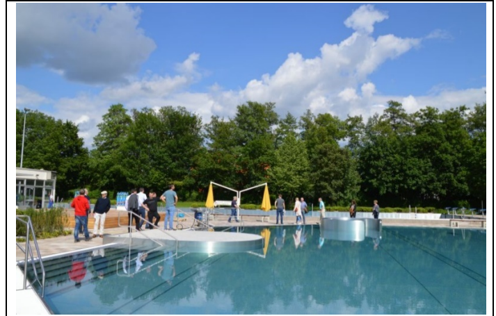
Startklar ist das komplett sanierte Remchinger Schlossbad, das der Gemeinderat dieser Tage besichtigte, vom Baufortschritt her – jetzt kommt es auf die Ausarbeitung und Umsetzung der corona-bedingten Landesvorgaben an, bevor die beliebte Einrichtung wieder öffnen kann. Foto: Frank Reichert
